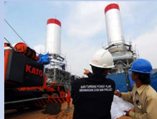
2 x 57 MW PLTG/ GTPP Keramasan, Sumatera Selatan/South Sumatera (Tidak Beroperasi)
