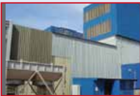
2 x 57 MW PLTG - GTPP Keramasan, Palembang, SUMATRA SELATAN (Tidak beroperasi) - SOUTH SUMATRA (Not Operating)
