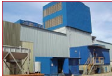
2 x 57 MW PLTG • GTPP Keramasan, Palembang, SUMATRA SELATAN • SOUTH SUMATRA
