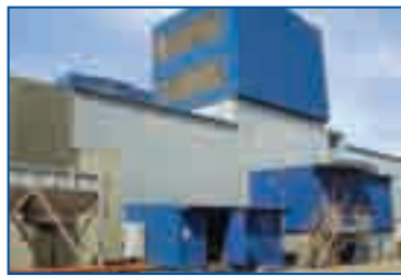
2 x 57 MW PLTG • GTPP Keramasan, Palembang, SUMATERA SELATAN • SOUTH SUMATERA
